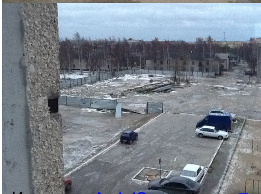
Источник: АиФ Югра Фото: Типичный Нефтеюганск
